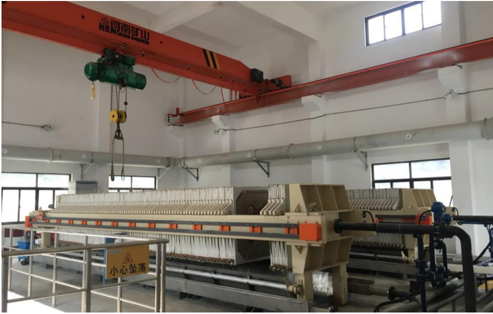
丽水庆元第二污水处理厂污泥深度脱水项目
