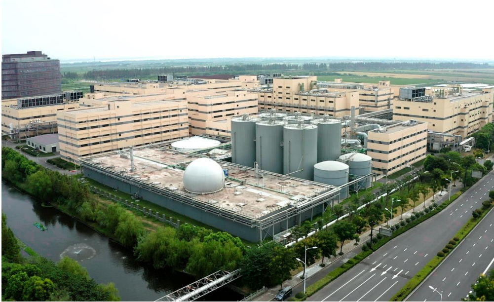
华东医药废水 EPC 总包项目
