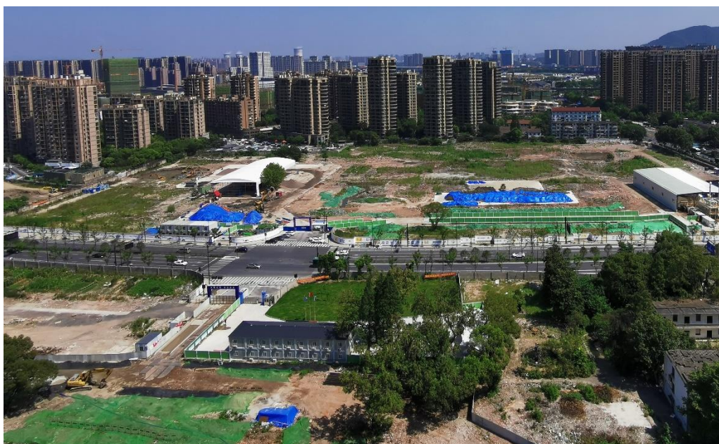
浙江新世纪金属材料现货市场退役地块修复工程项目
